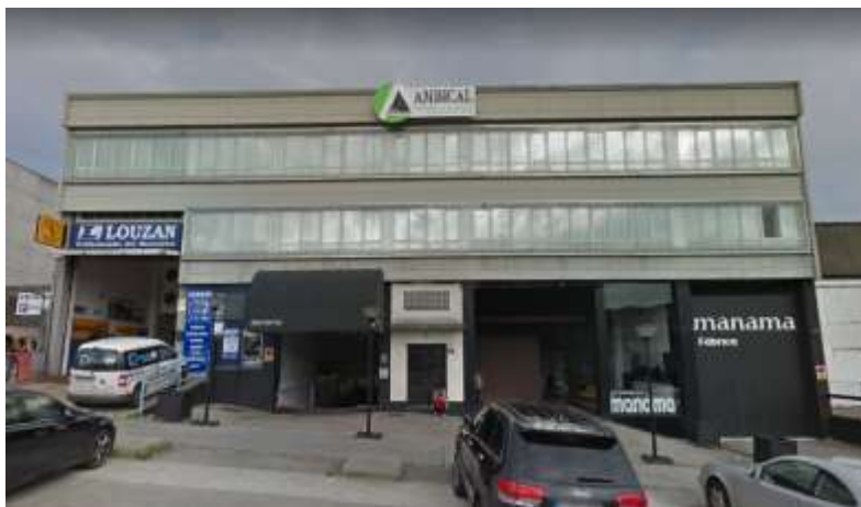
Figura 3.4 Vista Exterior de las instalaciones de Ambical
